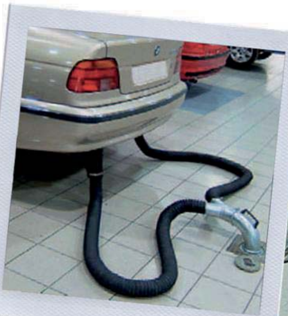
IMPIANTI FUMI DI SCARICO
