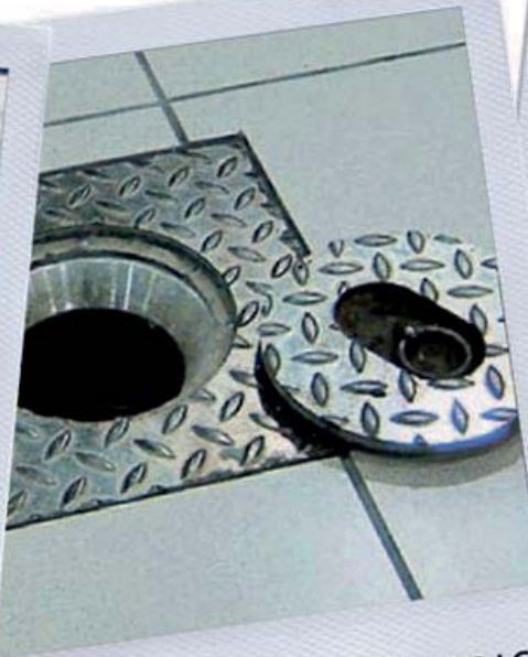
IMPIANTI FUMI DI SCARICO
